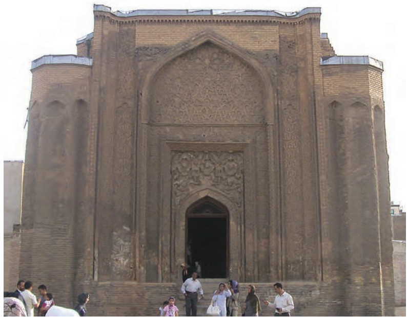
گنبد علویان از بناهای دوره سلجوقی - همدان
